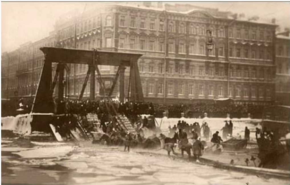
Рис. 11. Обвал Египетского моста
